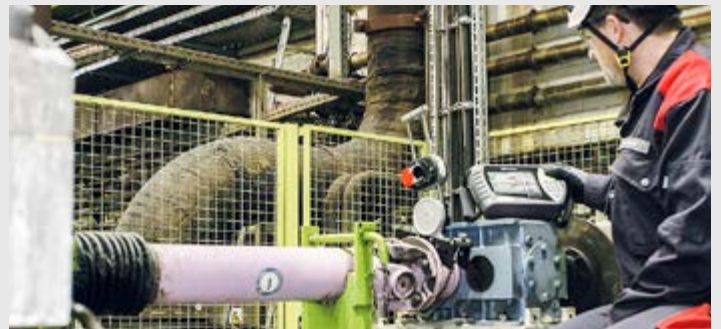
Ansicht beim Ausrichten mit ROTALIGN® Ultra iS und Schwenkvorrichtung
