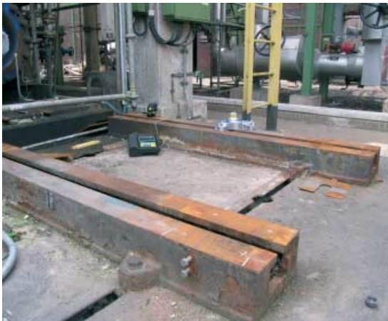
Gesamtüberblick Motorfundament, in Hintergrund die abgedeckte Welle der Prozeßpumpe
