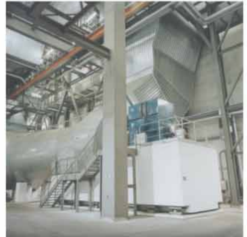
Frischlufventilator in einem Wärmekraftwerk
