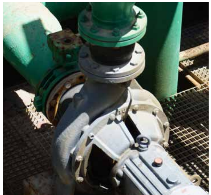
Das flexible Leitungselement schützt die Pumpe vor Belastung und Spannung
