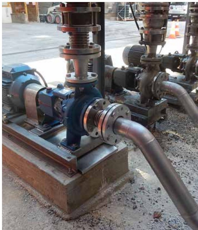
Nova placa de base do motor com parafusos de ajuste no local de produção de Montmeló
