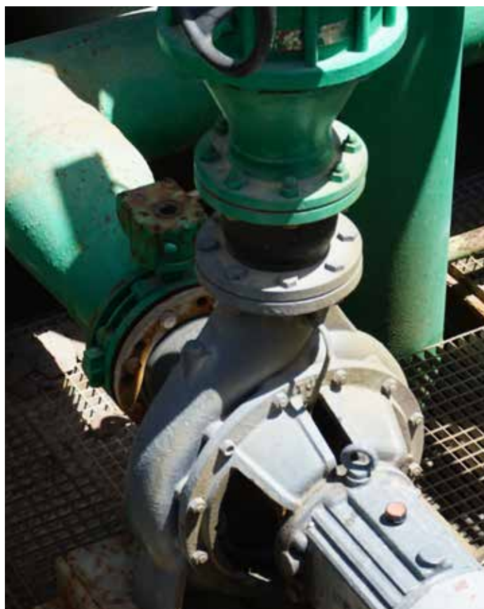
O elemento de tubulação flexível reduz a carga e a tensão na bomba
