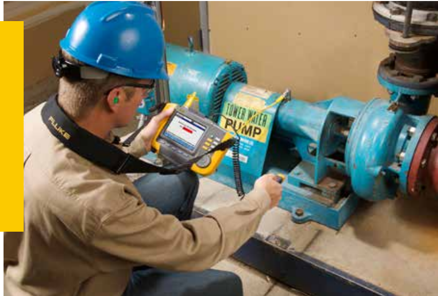
Entender el análisis de vibraciones puede transformar un sistema de "hacer funcionar hasta que se rompa" en un programa de mantenimiento proactivo basado en el estado.
