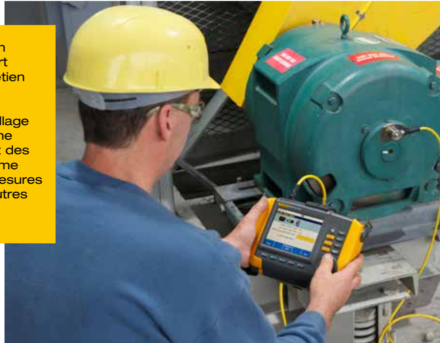
Le testeur de vibrations 810 surveille un moteur en fonctionnement.
