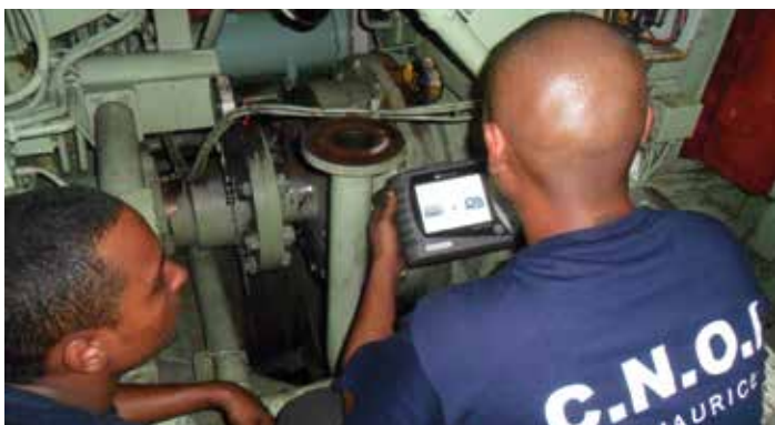
Messung der Wellenausrichtung mithilfe der ROTALIGN® Ultra iS Plattform
