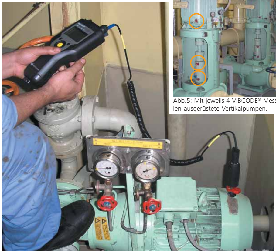
Abb.4: Mobile Messung am Lüfterseitigen Motorlager mit VIBSCANNER®
