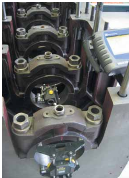
Abb.1: Lasertechnik zur Kontrolle der Lagergasse
